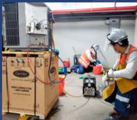
Recuperación de gas refrigerante.
