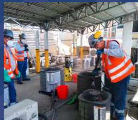
Proceso de lavado de condensadores A/C.
